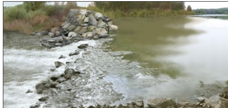
Enderrocament d'una resclosa per facilitar els desplaçaments dels peixos.
